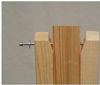
Auf die Schraube eine Unterlegscheibe schieben, anschließend die Schraube durch alle drei Hölzer stecken. Auf der anderen Seite wieder eine Unterlegscheibe aufschieben und eine Flügelmutter andrehen.
